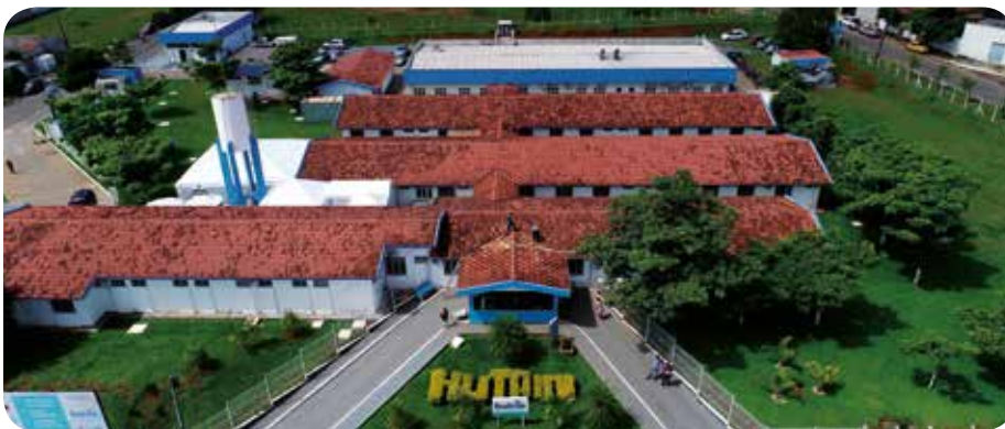
Visão aérea do Hutrin. Unidade instalou duas tendas climatizadas para dar mais conforto e agilidade no atendimento
